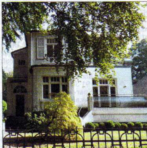
Im Souterrain des Hauses könnte problemlos ein Au-pair untergebracht werden.
