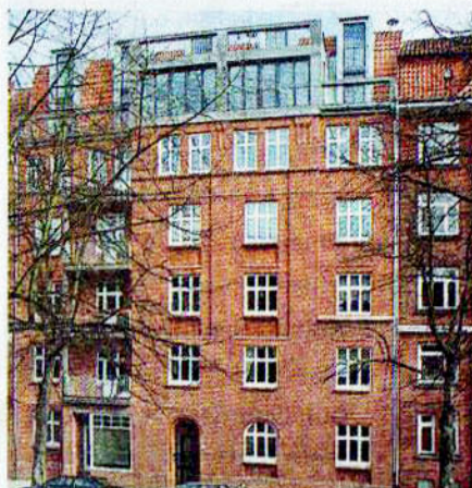
Der Dachausbau am Paulsenplatz harmoniert mit der Hausfassade.
